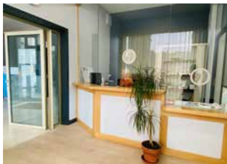
■ RÉAMÉNAGEMENT DE L'ACCUEIL, CRÉATION DE NOUVEAUX BUREAUX AU REZ-DE-CHAUSSÉE
