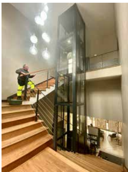
■ ACCESSIBILITÉ : INSTALLATION D'UN ASCENSEUR
