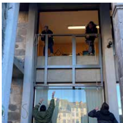
■ REMPLACEMENT DE LA TOTALITÉ DES FENÊTRES ET OUVERTURES
